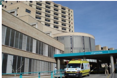
Acceso a Urgencias- Bloque Sur.
