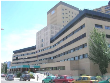
Acceso Principal- Bloque Norte.
